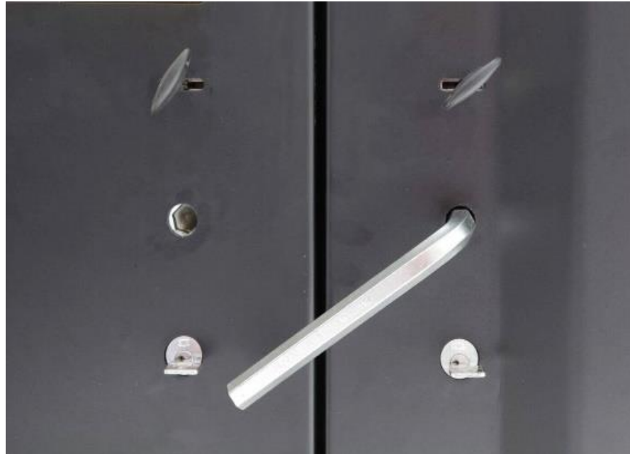
Figura n° 56 Accesso con chiavi di sicurezza
