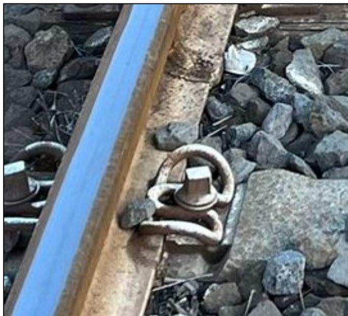
Figura 6: Sistema di attacco diretto elastico
